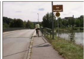
Auch die alte Niederwölbacher hatbrücke ist zwischenzeitlich erneuert.
