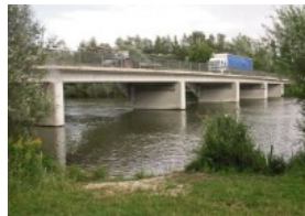
Die alte, zwischen abgelehnten Mannstegger hatbrücke.
